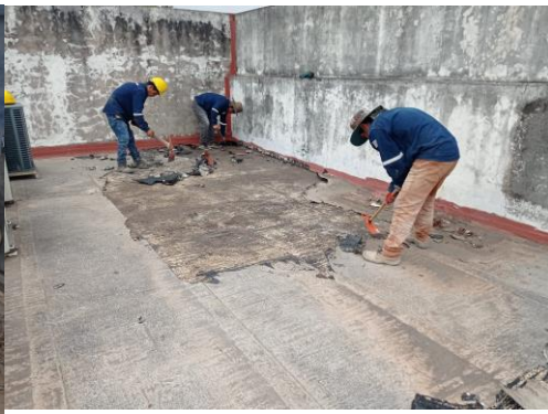
Limpieza cubierta
